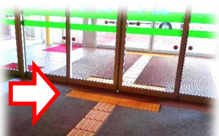
誘導ブロックから警告ブロックへ
